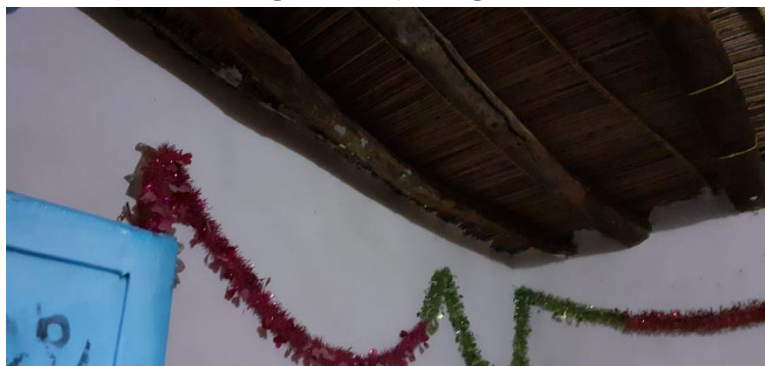
تصویر ۳۲- تخریب سقف منازل در محله دمبیگان (با توجه به وجود سیل‌بند سیل در این بخش متوقف شده و تنها باران موجب بروز این تخریب‌ها شده است)
